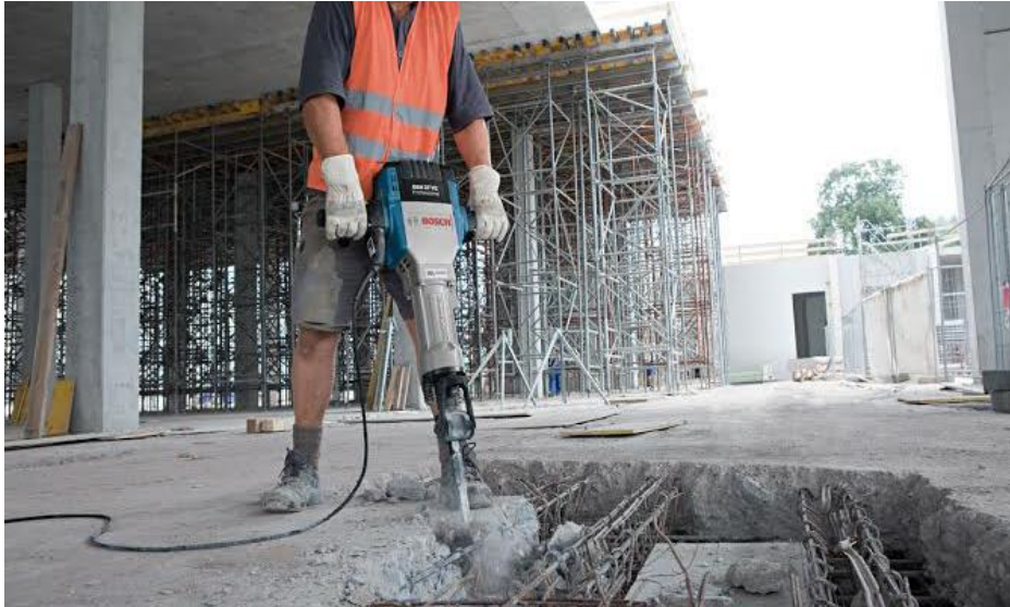
Hình 41 - Phá bê tông
