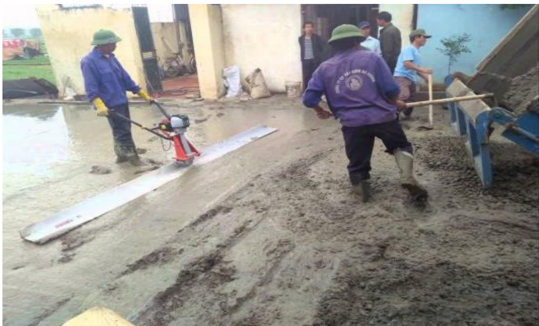
Hình 43 - Đầm rung bê tông
