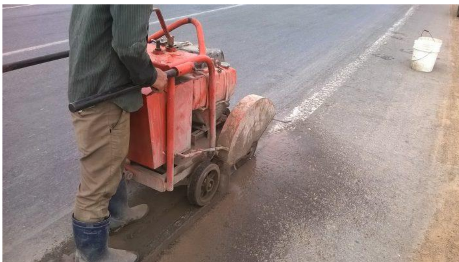
Hình 42 - Cắt mặt đường bê tông
