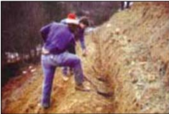
Hình 31. Đào rãnh trên taluy đường
