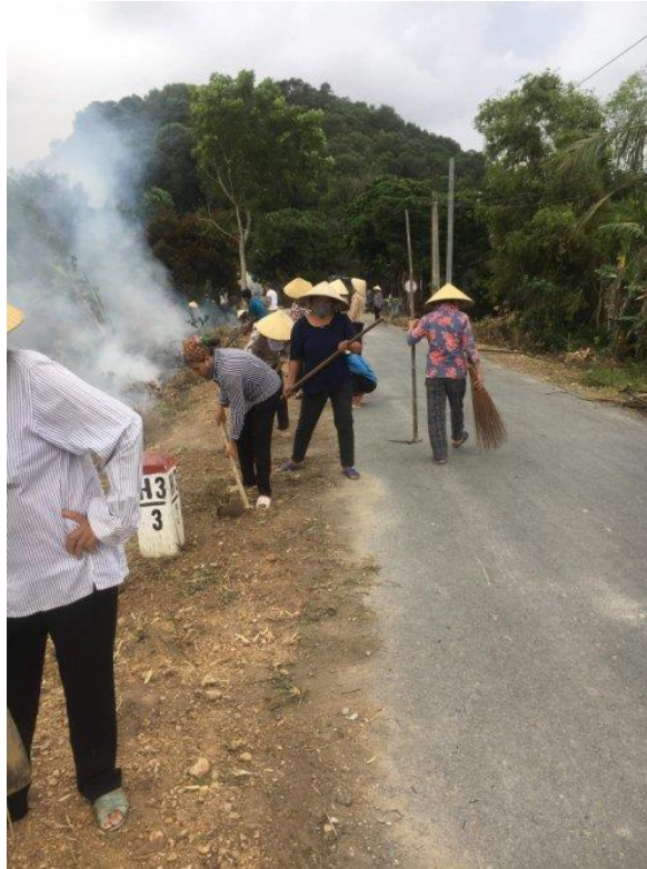
Hình 19. Công nhân đang dọn dẹp lề đường
