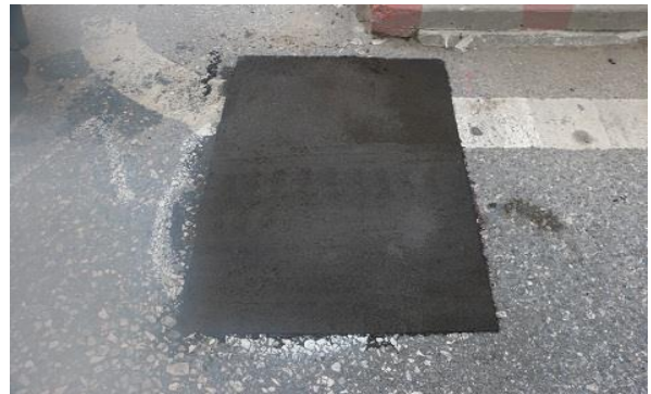
Ổ gà sau khi đã được xử lý
