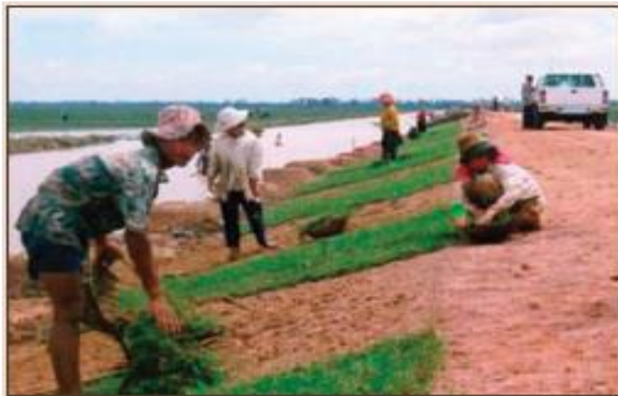
Hình 21. Cộng đồng trồng cỏ trên mái taluy đường
