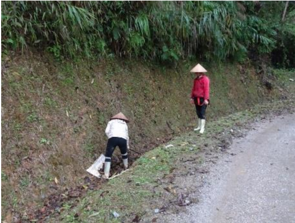
Hình 10 – Công nhân đang dọn dẹp lá khô, rác trong rãnh không lát đá
