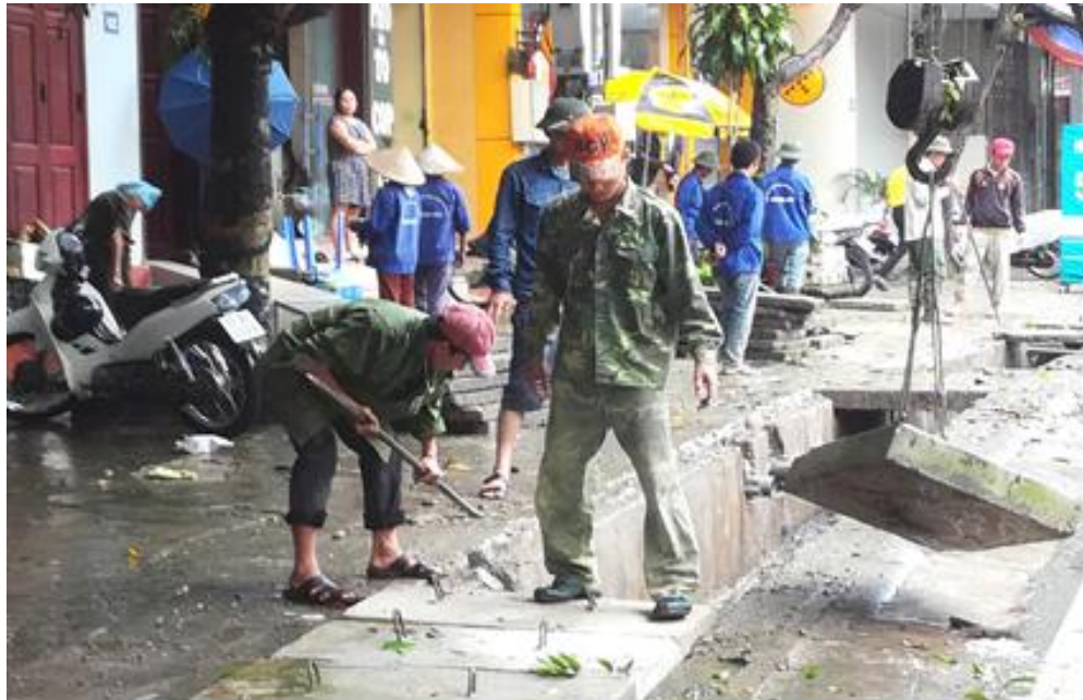
Hình 12. Hoạt động sửa chữa rãnh xây có nắp đậy tại khu dân cư
