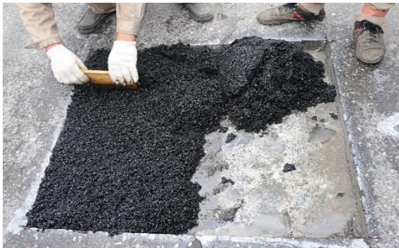
Vật liệu nguội đổ vào điểm vá đã được làm sạch
