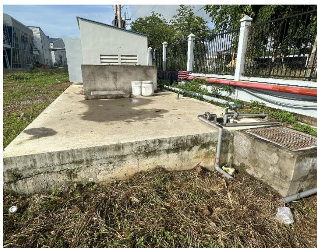
Trạm xử lý nước thải hiện hữu
