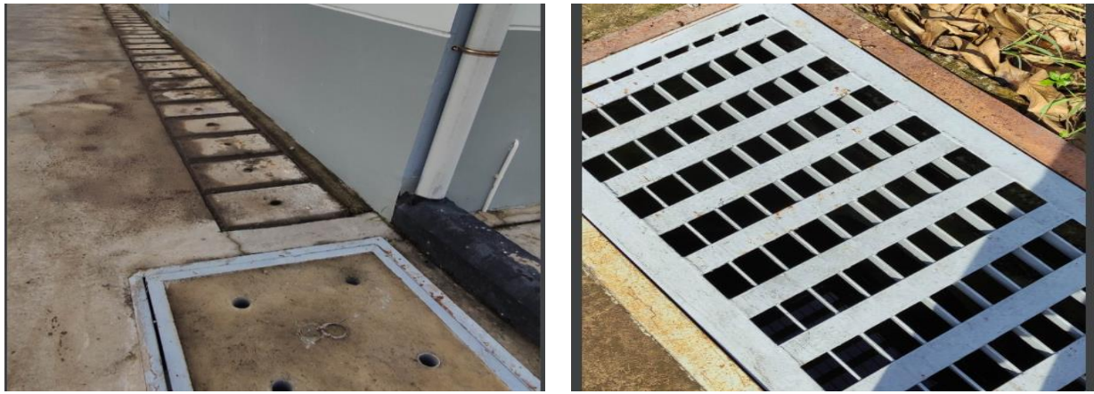
Mương thoát nước mưa dự án hiện hữu
