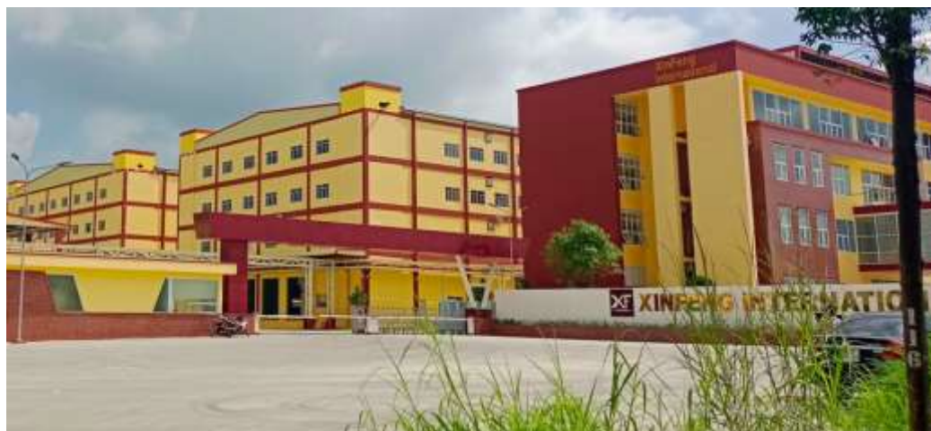
Hình 1. 18. Nhà xưởng 1, 2 và văn phòng đã xây dựng hoàn thiện.
