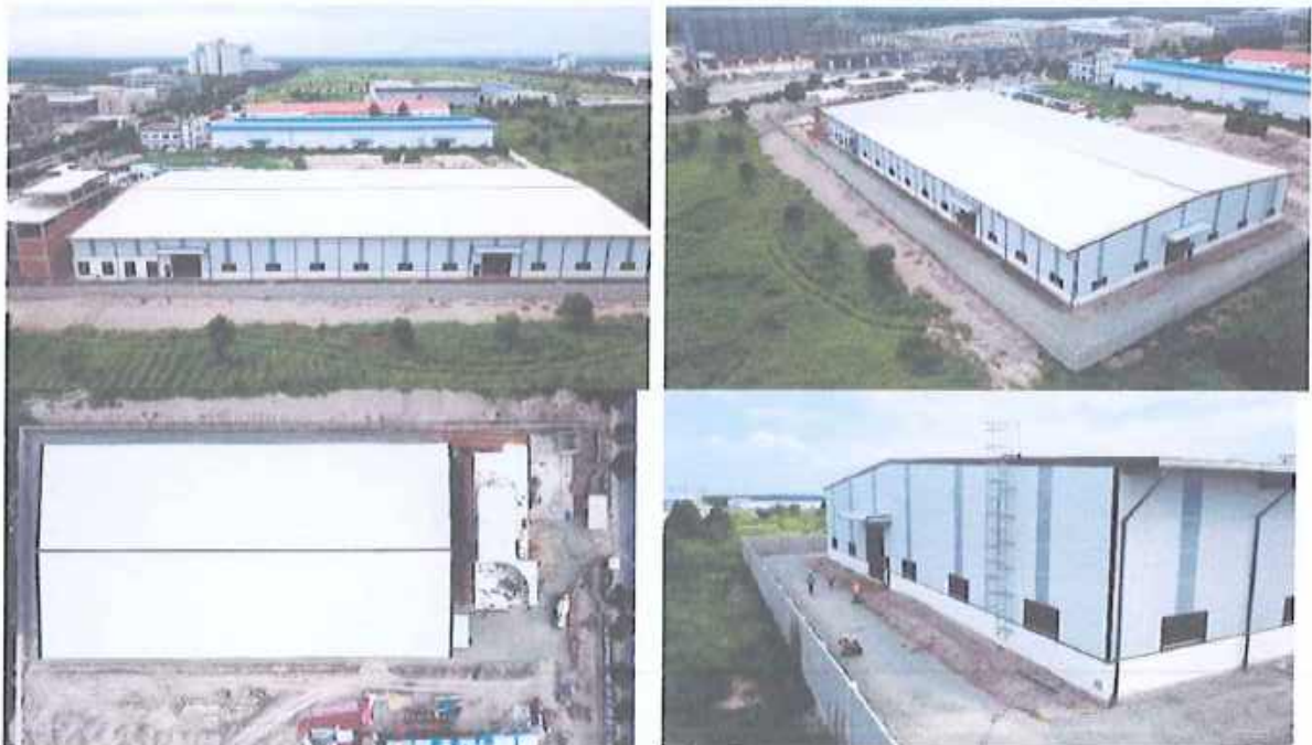
Hình 1-3 Hiện trạng công trường đang thi công
