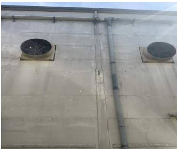
a) Hệ thống thu nước mưa trên mái nhà
