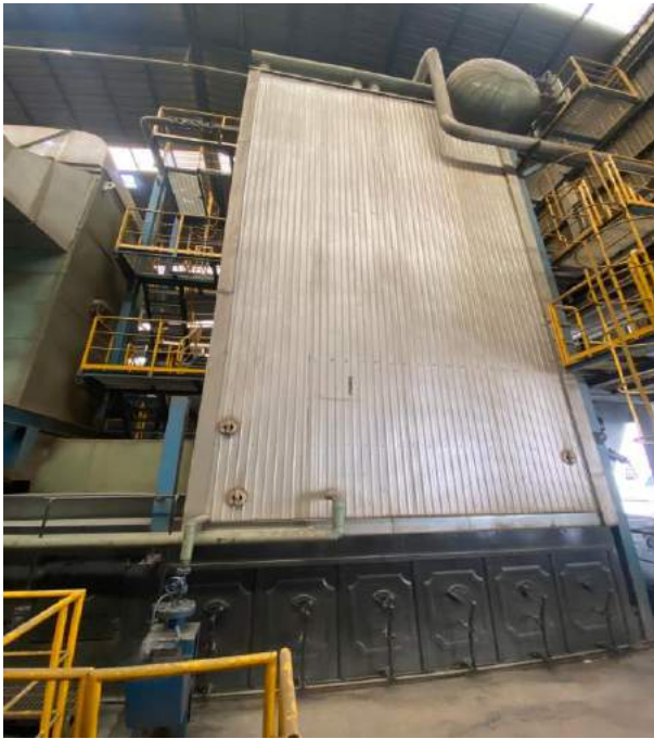
Lò hơi, công suất 19 tấn hơi/giờ
