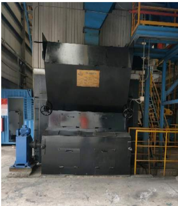
Lò nhiệt công suất 6.000.000 kcal/giờ
