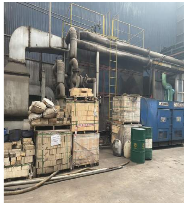
Lò nhiệt công suất 4.000.000 kcal/giờ (dự phòng)
