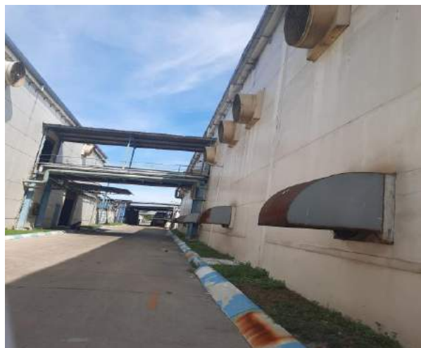
b) Hệ thống thu nước mưa chảy tràn trên mặt đường giao thông nội bộ, sân, khuôn viên dự án
