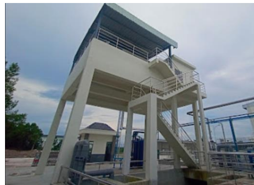
Nhà để máy ép bùn
