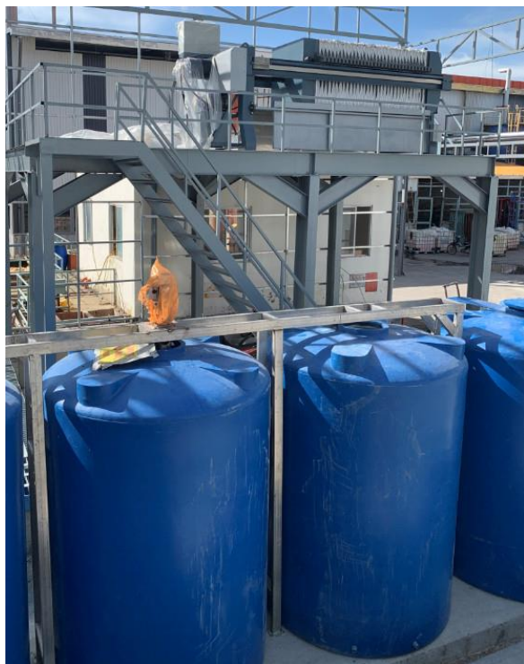
a) Khu vực bồn hóa chất và máy ép bùn
