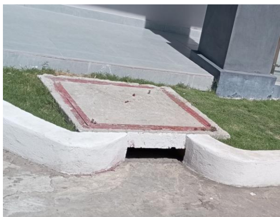
a) Hố ga thu nước mưa tại dự án đầu tư b) Vị trí đầu nối hố ga nước mưa KCN
