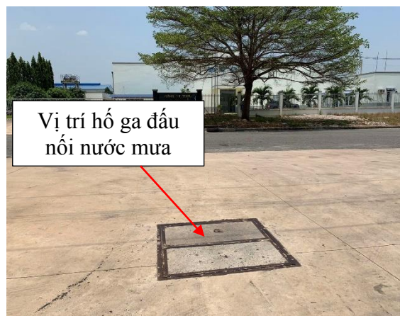
a) Hố ga thu nước mưa tại dự án đầu tư b) Vị trí đầu nối hố ga nước mưa KCN
