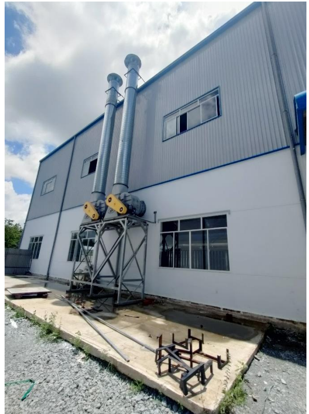
Hình 4.12 Hệ thống thu gom và xử lý bụi ở khu vực sơn
