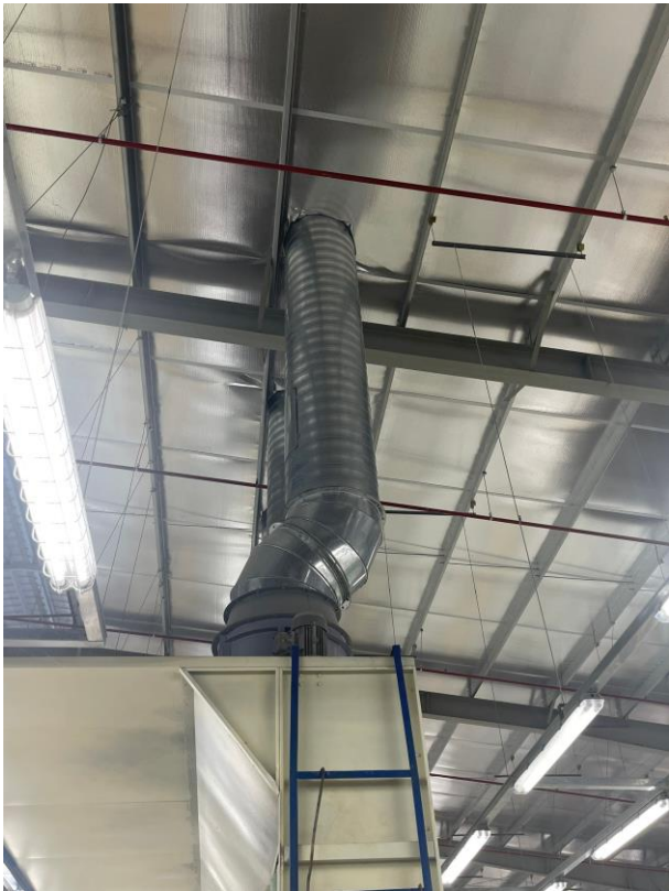
Hình 4.12 Hệ thống thu gom và xử lý bụi ở khu vực sơn
