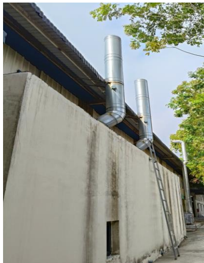
Hình 13. Hình ảnh hệ thống xử lý sol khí của quá trình phun gelcoat.
