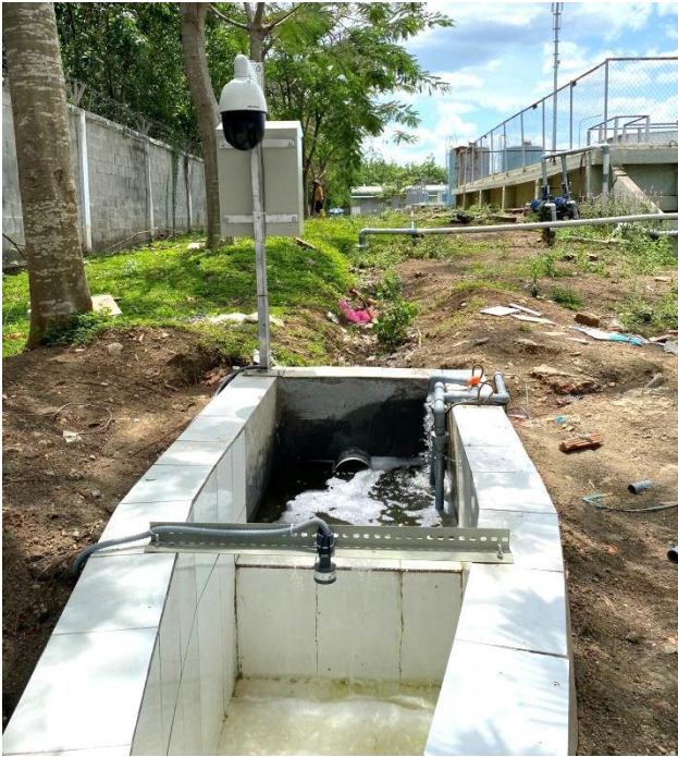
Mương quan trắc tự động, camera, đầu cảm biến
