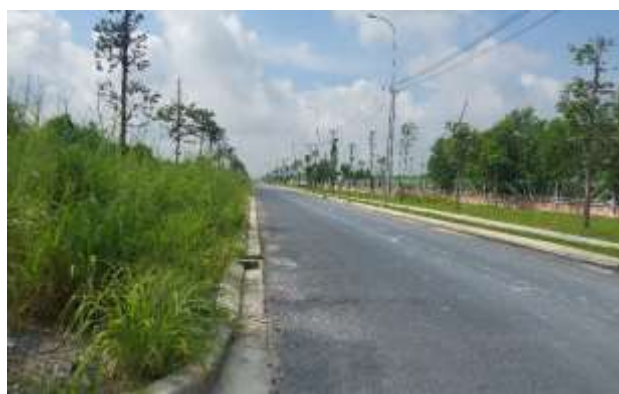
b. Đường nội bộ D3 KCN Minh Hưng – Sikico tiếp giáp phía Tây dự án
