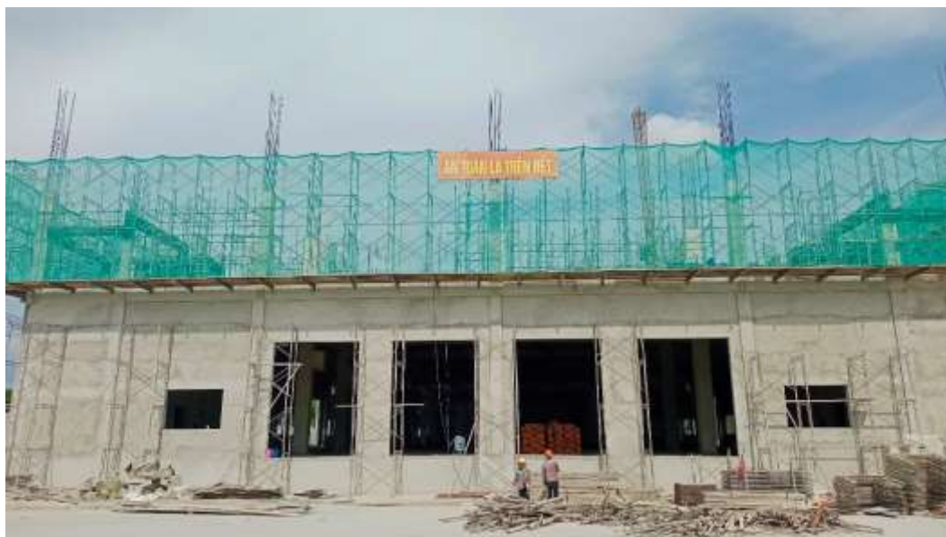
Hình 1. 19. Nhà xưởng 4 đang xây dựng.
